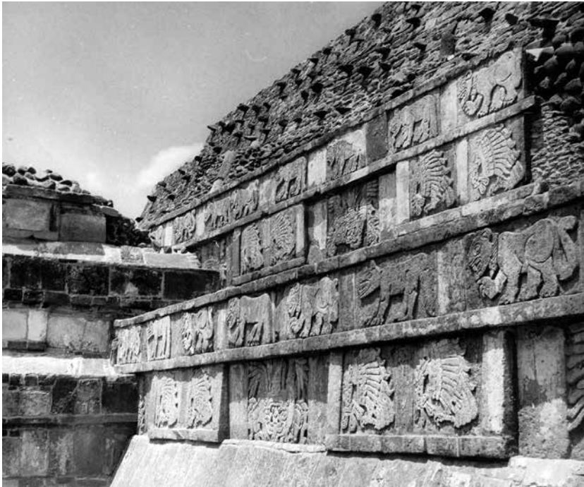
Foro 260-A. Vista general de los Tableros del Edificio B, lado Este.
