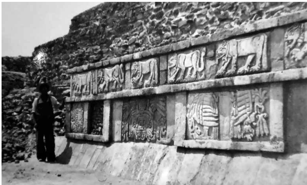
Foro 260-A7. Los Tableros del Edificio B en su lado Norte.
