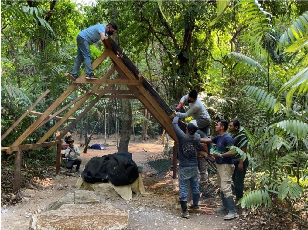
Figura 4.13 Altar 1. Proceso de construcción de cubierta protectora. Foto. Griselda Pérez Robles. 2021
