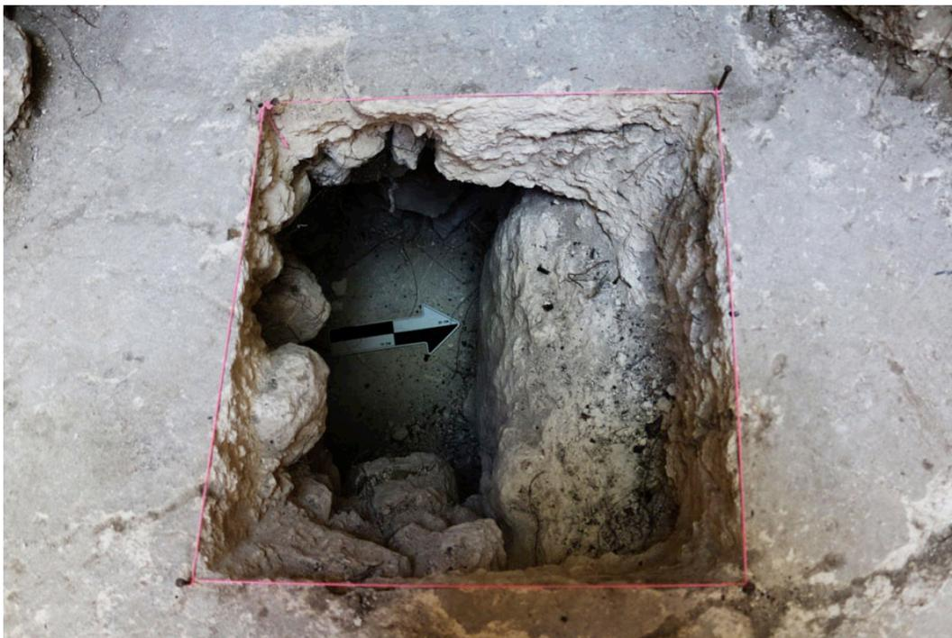
Foto 3.7. Capa de estuco y relleno de construcción, descubiertos en el Registro #2 (Foto: M. Rangel).
