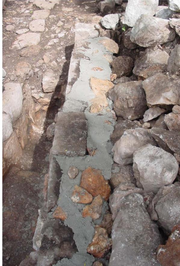
Figura 3.17. Cala 7, Cuadro D7. Proceso de consolidación de la plataforma adosada.
