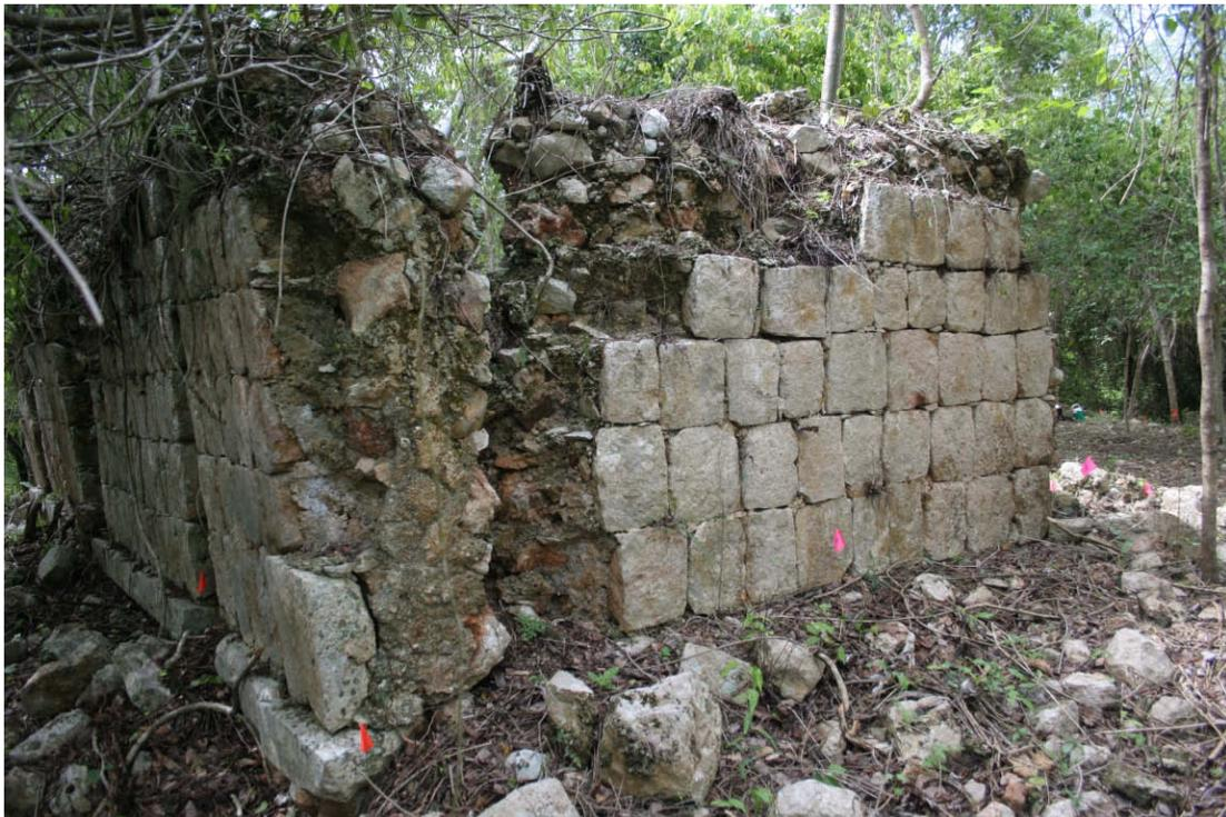
Figura 2.9. La esquina noroeste de la Estr. N5020E5240. La mampostería está preparada para una futura ampliación (IMG\_1421).
